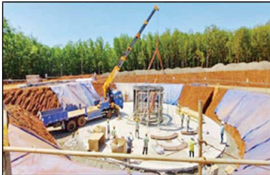
Κατασκευή θεμελίου-βάσης αγκύρωσης πυλώνα Α/Γ.
