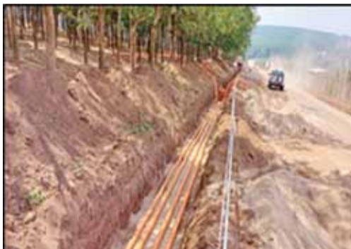
Κατασκευή υπογείου δικτύου Μ.Τ. εντός χώρου Α/Π.
